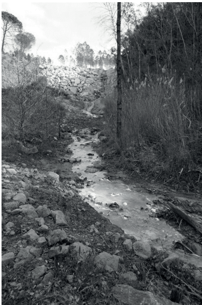
Figure 2: Digue et Reigous
